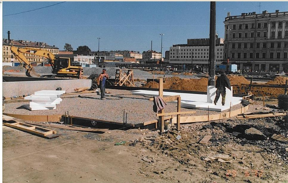
В основании площади - плотный пенополистирол KNAUF Therm.
